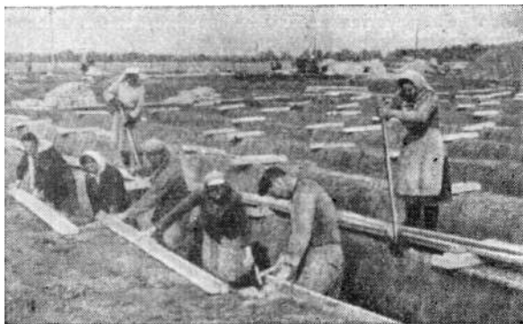
Строительство парников в колхозе.
