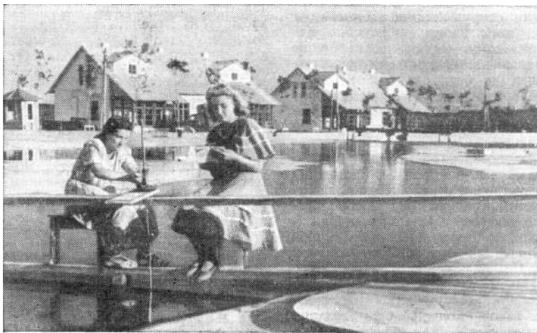
Модель Сталинградского гидроузла, расположенная на площади в 2 гектара. Русло модели отображает в миниатюре все характерные особенности Волги в районе створа плотины. На снимке: инженер Н. Н. Козлова (слева) и техник Т. С. Герасименко измеряют скорость течения воды в русле «Волги».
