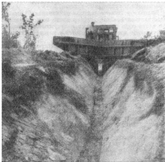
Канавокопатель на прокладке осушительных канав.
